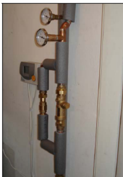
Tömegáramszabályzás visszacsapószeleppel a gyakorlatban
